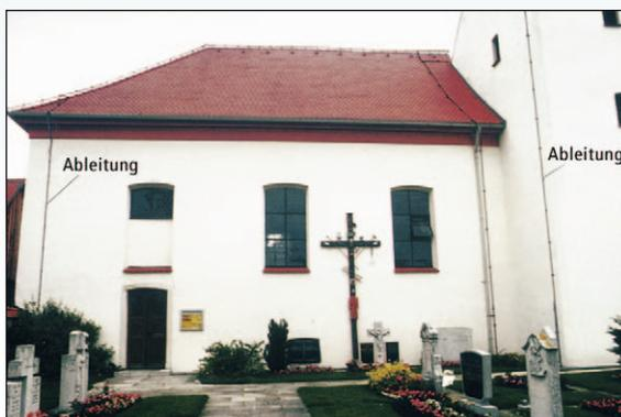
Bild 1 Äußerer Blitzschutz des Kirchenschiffs
