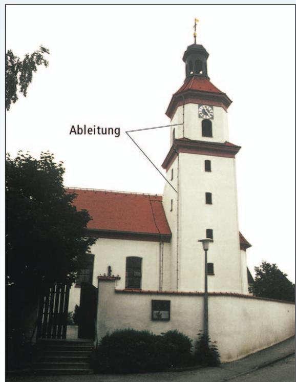
Bild 2 Verlegung der Ableitung am Kirchturm
